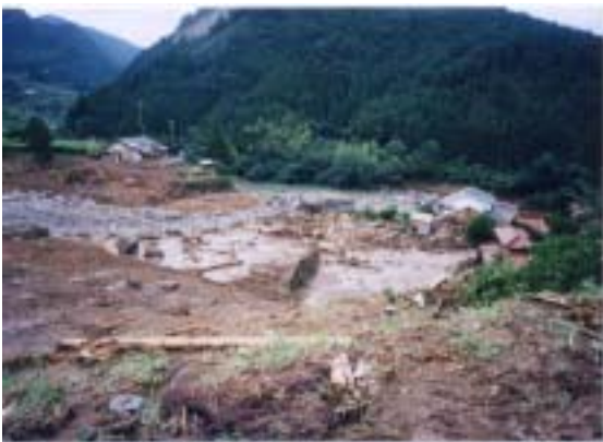
写真 - 6 家屋の被災状況
