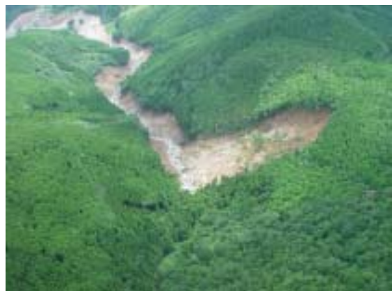
写真 - 7 土石流の流下痕跡（偏流）
