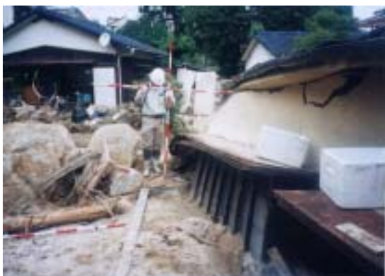
写真 - 5 合流点付近の堆砂域における被災家屋
