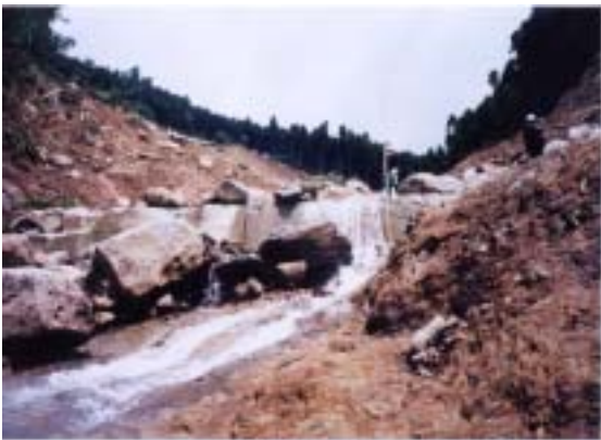
写真 - 8 最上流のコンクリート谷止工の被災状況
