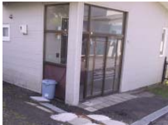
斜面下方の隣家（基礎が確認できない）
