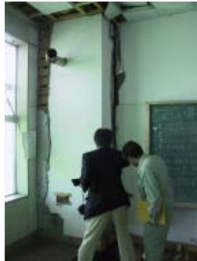
3階鉄骨造部分
