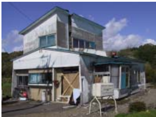
駅近くの木造住宅（南側）
