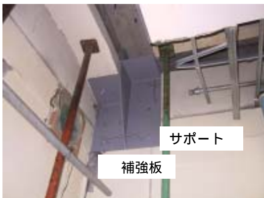
1階 梁及び床の破断部分
