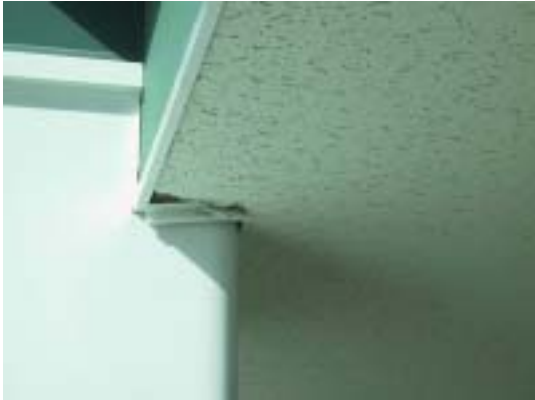
西側 天井と柱との取り付け部分
