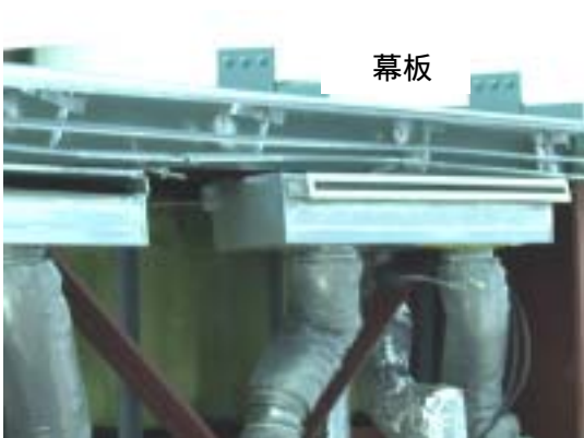
東側 噴出し口付近 見上げ
