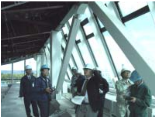
東西方向には角形鋼管のブレース
