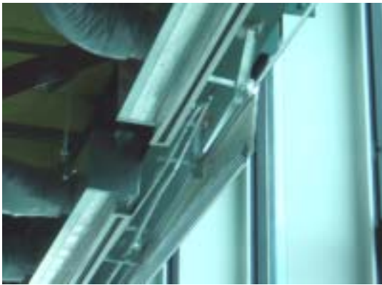
東側 噴出し口付近
