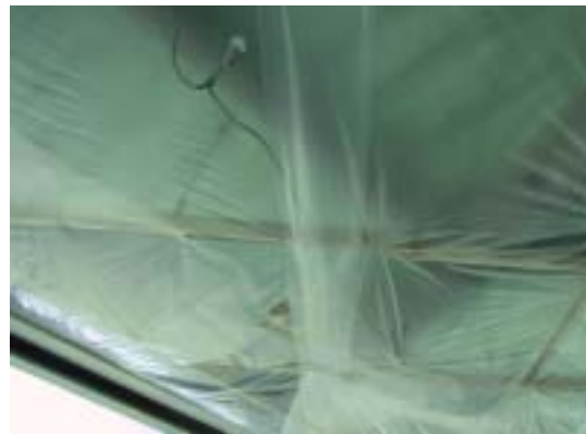
外観 (耐火被覆の落下防止用のビニールを留めるため、木材を仮設している。)
