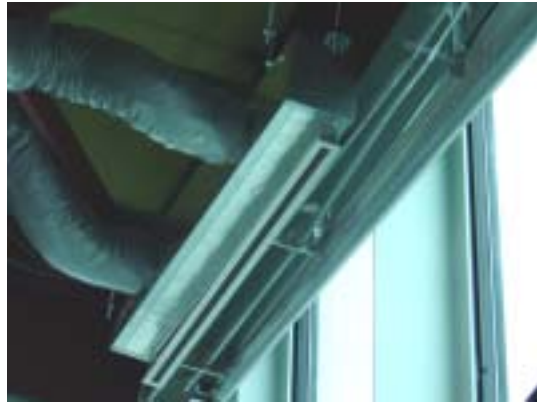
東側 噴出し口付近
