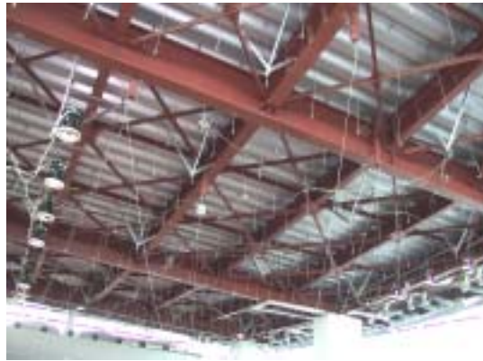
調査当日の屋根見上げ（仕上材を除去した後）
