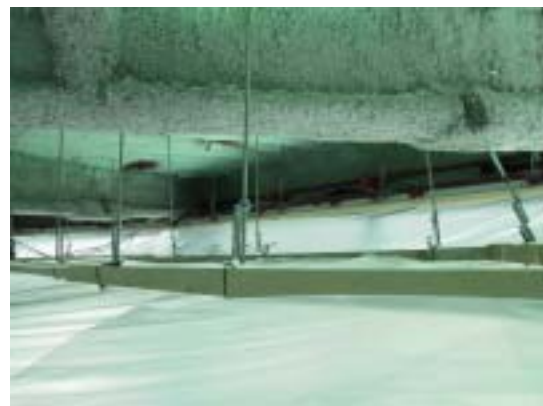
管制塔の天井
