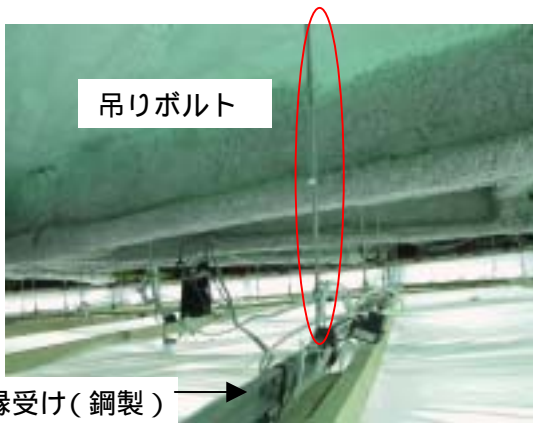
管制塔の天井
