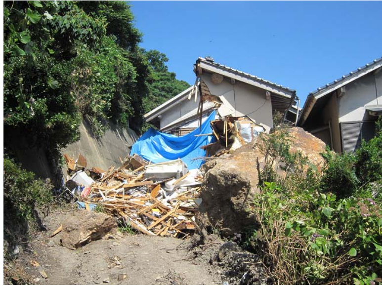
写真1 被災した民家（手前の岩塊は径 4m 程度）
