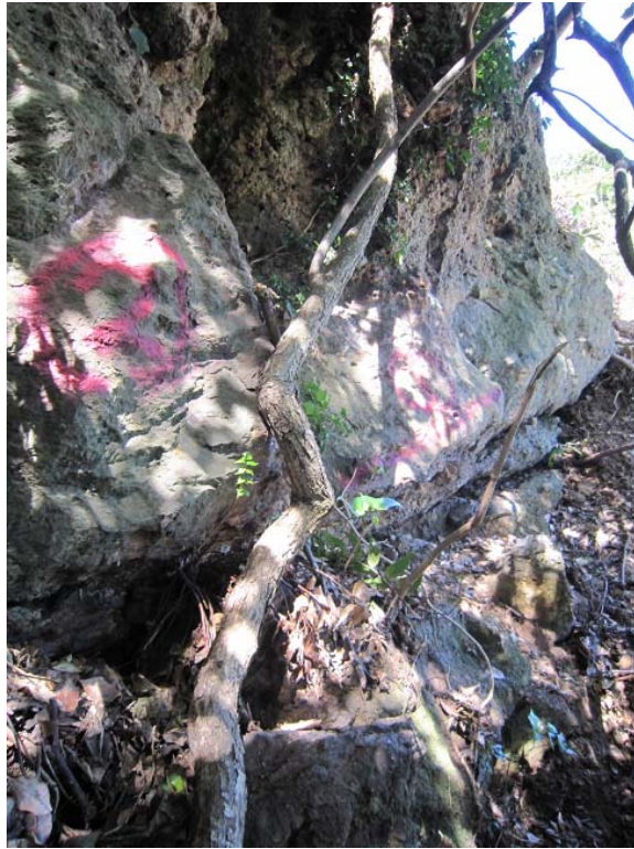
写真 5 崩壊地右岸側の様子（凝灰岩のブロックの間に頁岩の層が挟まっている）
