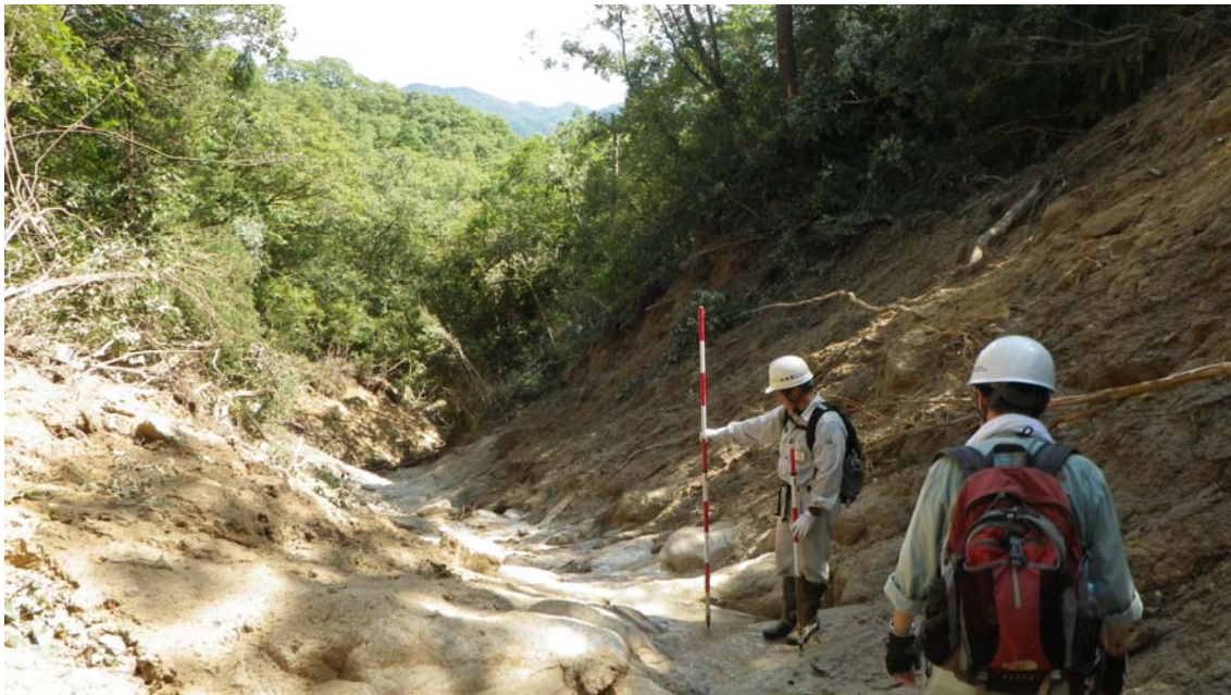
写真4 流下区間の状況2
