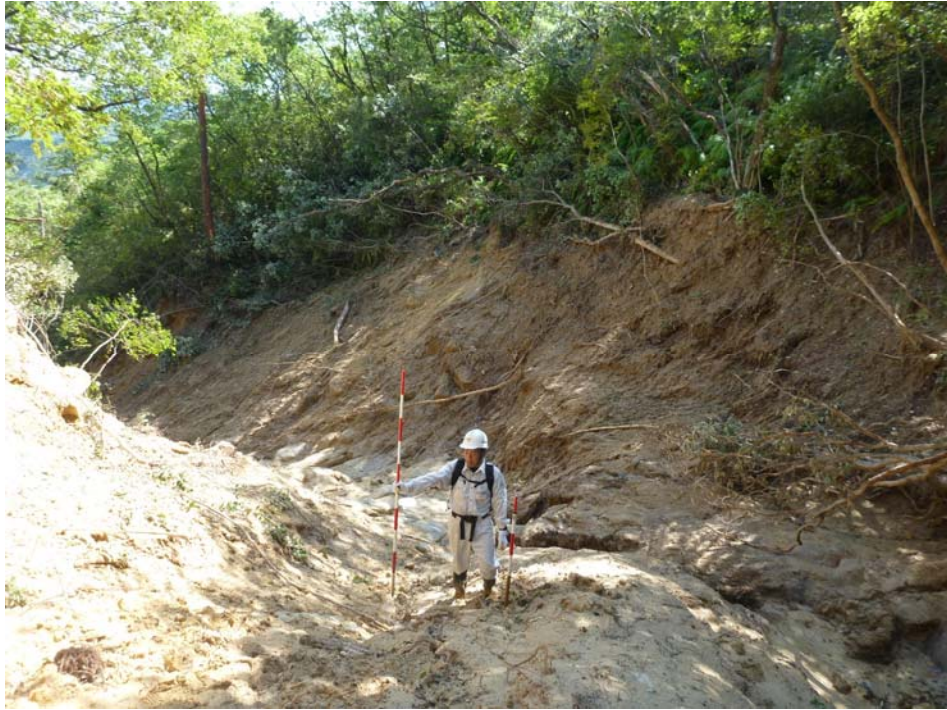
写真3 流下区間の状況1
