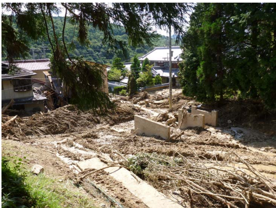
写真 5 谷出口左岸側から氾濫区域を望む
