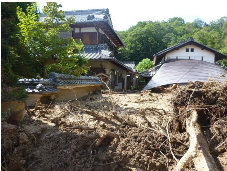
写真 6 氾濫域における土砂が流入した家屋
