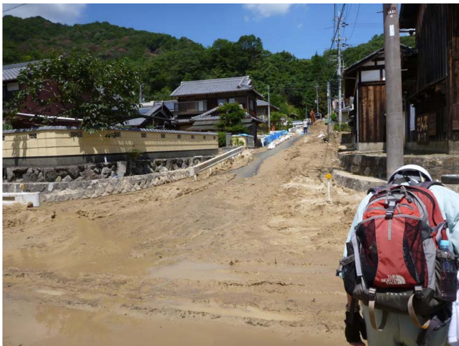
写真7 道路に氾濫した土砂の状況
