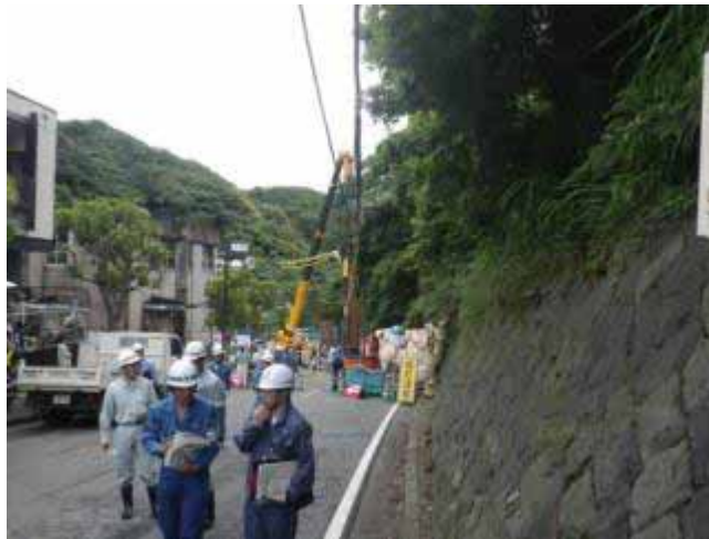
写真-9 間知石積み擁壁の状況
