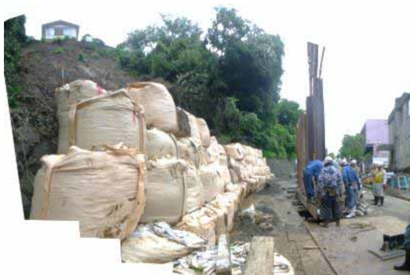
写真-4 仮設防護柵設置状況
