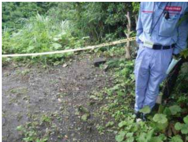
写真-6 斜面上部の宅盤の状況
