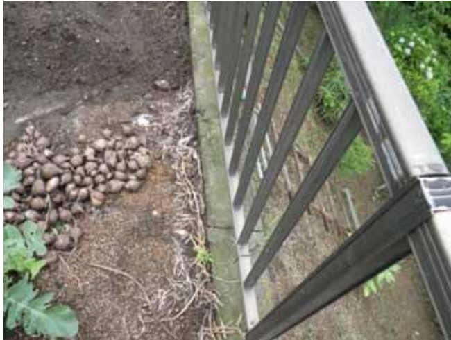
写真-8 既存宅地擁壁天端のクラック
