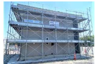
実大木造住宅実験棟を利用して各種の仕様による外壁の乾燥性能を評価
