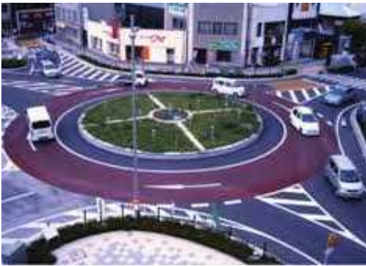
停電時でも安定して交通制御が可能なラウンドアバウト交差点の整備事例 (茨城県日立市)
