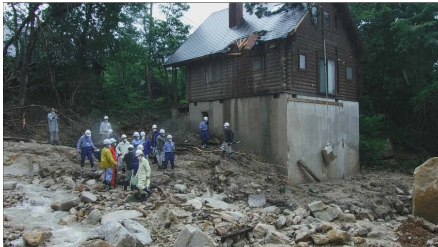
土石流の流下状況の調査(7月14日)
