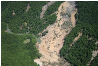
写真 岩手・宮城内陸地震で生じた天然ダムの例
