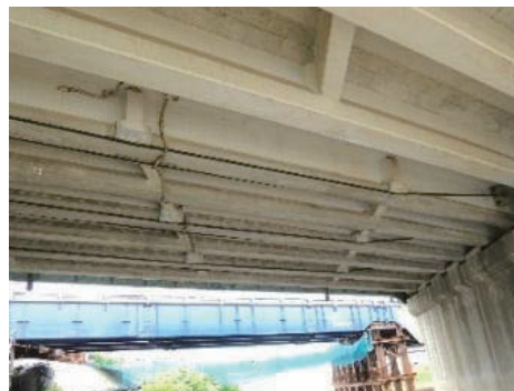
写真-1 外ケーブルを用いた橋梁の補強
