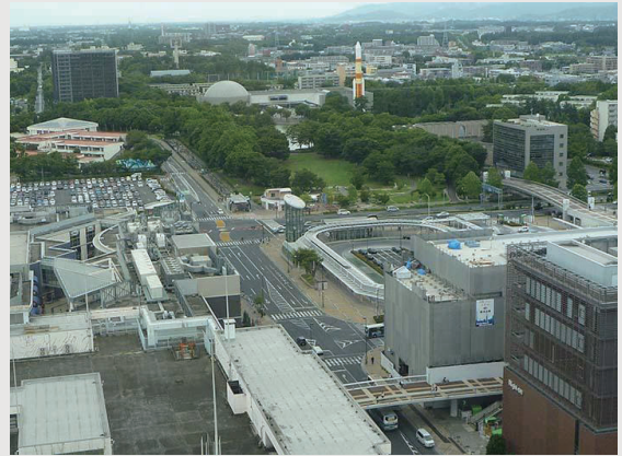
写真1 地下のTXつくば駅と交通広場
