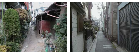
写真1 防災上危険な密集市街地の様子
