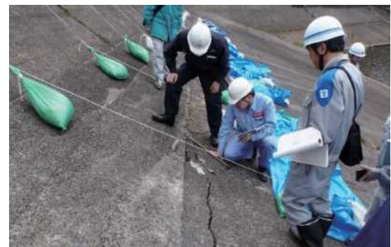
写真-2 地蔵原ダムでの調査状況(堤体上流面)
