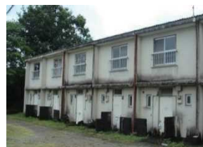
写真3 既存公営住宅団地内 の老朽化した除却予定の住棟
