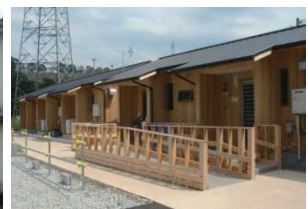
写真4 恒久住宅として利用 ニーズのある木造応急仮設住宅
