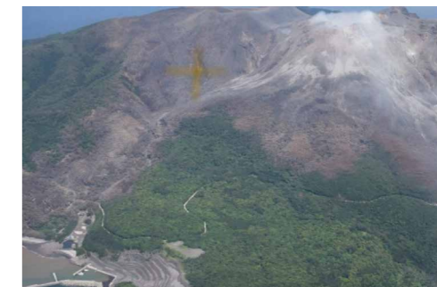
写真 向江浜川(口永良部島・鹿児島県) ※九州地方整備局より提供
