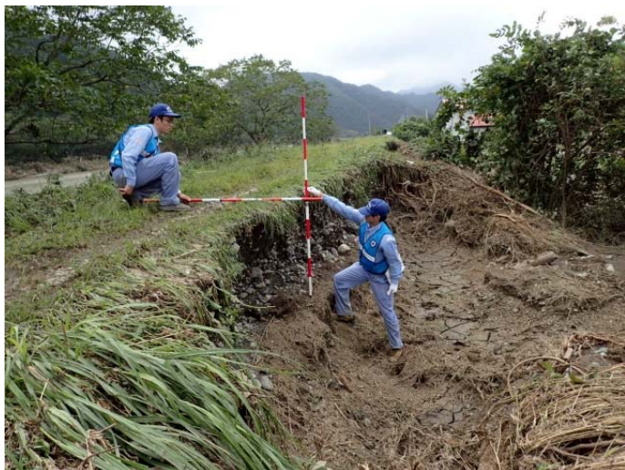
小本川にて堤防の越水被害状況調査を行う 国総研河川研究室、水循環研究室職員(9月3日)
