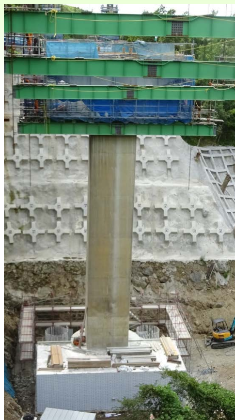
法面対策と増杭を実施している俵山大橋
