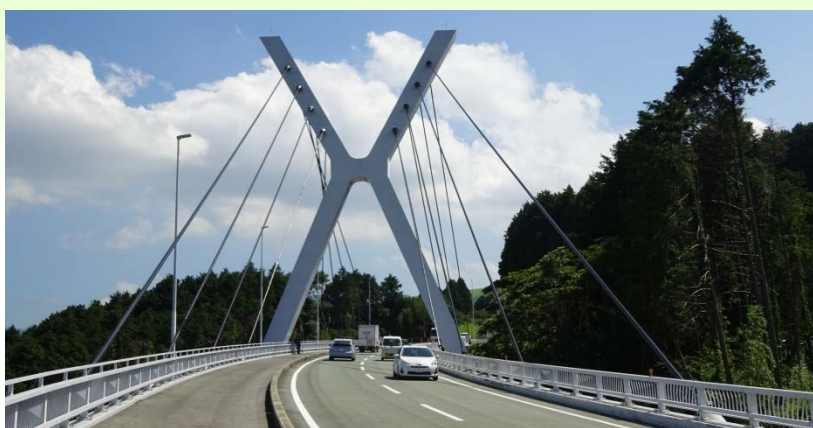
平成30年7月に供用を再開した桑鶴大橋
