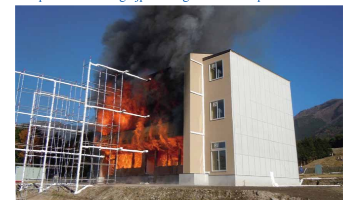
1階と2階に火災が拡大した点火後137分時点の様子
