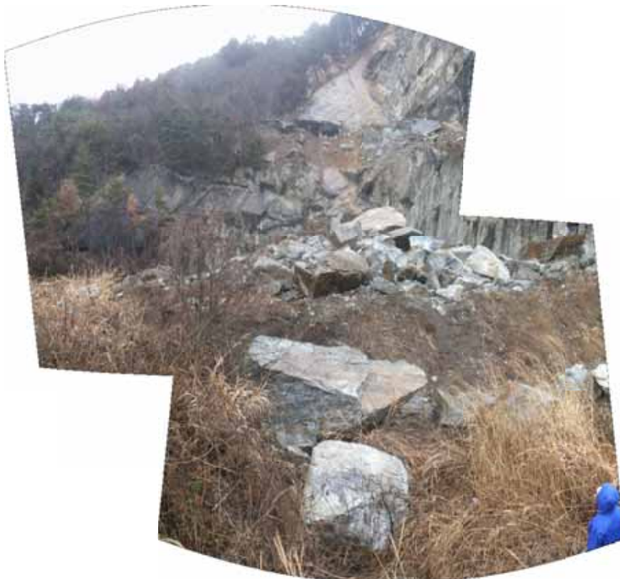
写真-5 崩落した岩塊の移動状況
