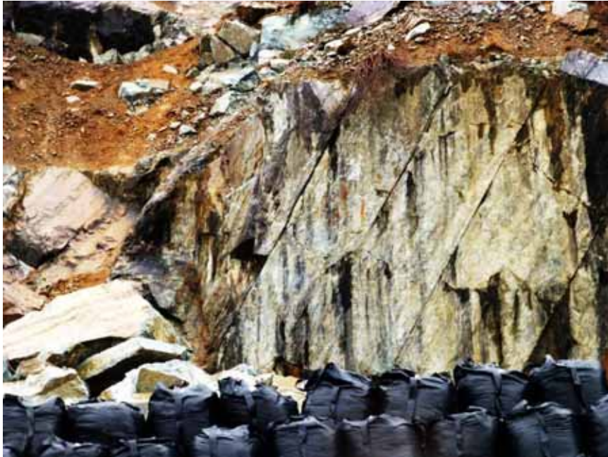
写真-3 亀裂の分布状況
