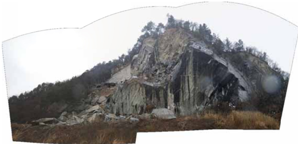
写真-1 崩落が発生した斜面の全景
