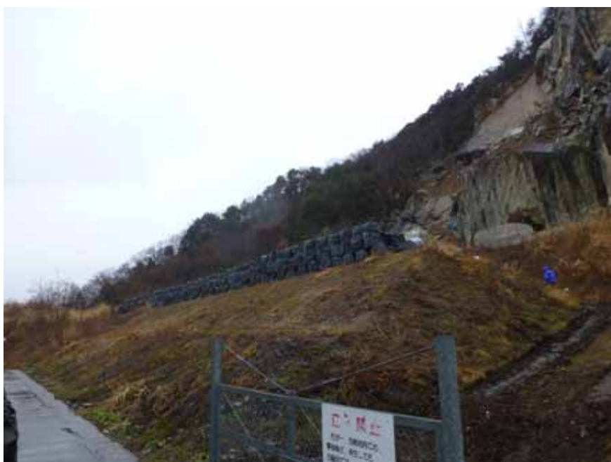
写真-10 石巻市が設置した土のう積みの設置状況
