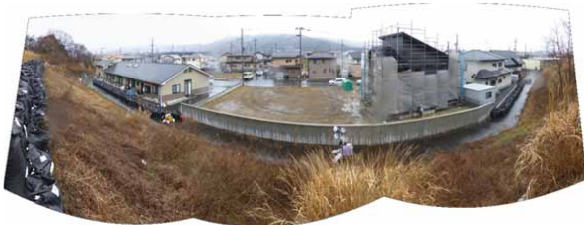
写真-9 斜面に近接した家屋等の全景
